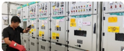
水电气中断演练
